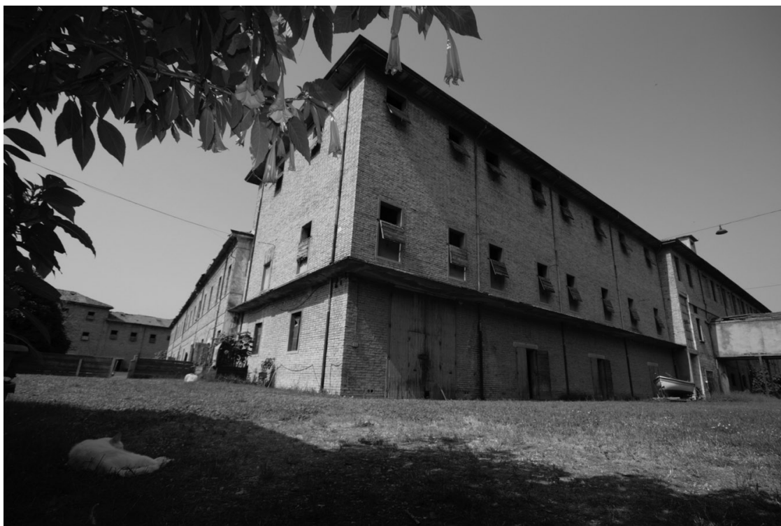
Sacta: edificio interno (foto di Chiara Pascucci).
